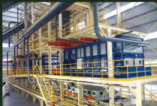
引进德国迪芬巴赫公司成套设备中的定向铺装系统；
