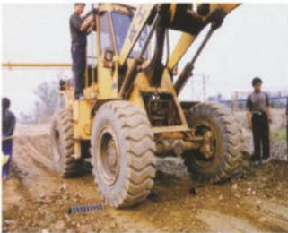
8吨重型掘土机直接碾压
